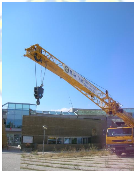
Inizio lavori a Roio
